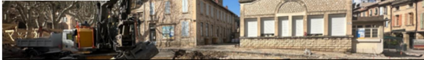
Sur le terrain, les candélabres ont été déposés, les arbres protégés, et la chaussée entièrement décaissée, laissant place à une large emprise de chantier prête pour les interventions en profondeur. Les travaux actuels concernent également le déblaiement, la préparation des fondations et le déploiement des réseaux souterrains (eaux usées, eaux pluviales, eau potable, éclairage).
